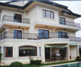
İstanbul, Acarlar villa Toprak Kaynaklı Isı Pompası
