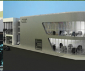
İstanbul, Audi - WW Showroom Su Kaynaklı Isı Pompası
