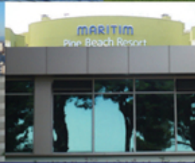
Antalya, Maritim Pine Beach Otel Toprak Kaynaklı Isı Pompası
