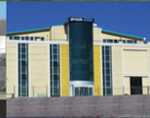
İstanbul, Etiket Fabrikası Toprak Kaynaklı Isı Pompası
