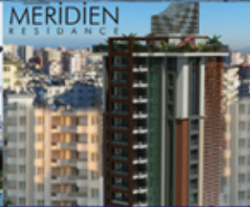
Adana, Meridien Residence Toprak Kaynaklı Isı Pompası
